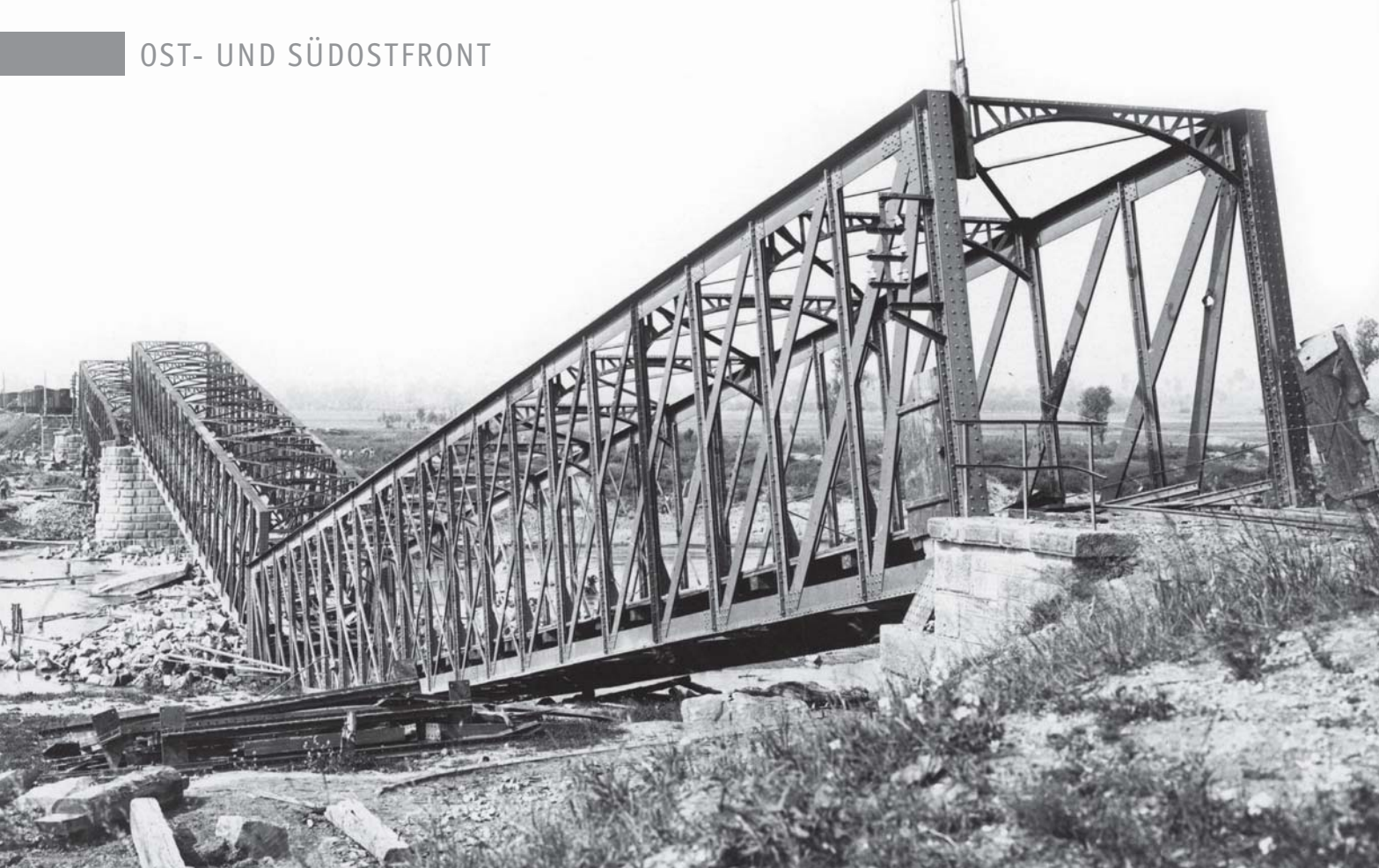
Rückeroberung Galiziens: Die Brücke über den San war durch Sprengung der Fachwerkträger und eines Pfeilers zerstört worden.
