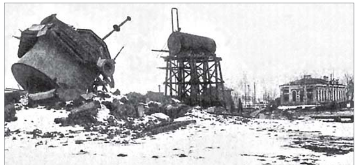
Als Ersatz für den von Russen gesprengten Wasserturm errich- ten Eisenbahnpioniere einen Petroleumbehälter auf Holzunterbau.
