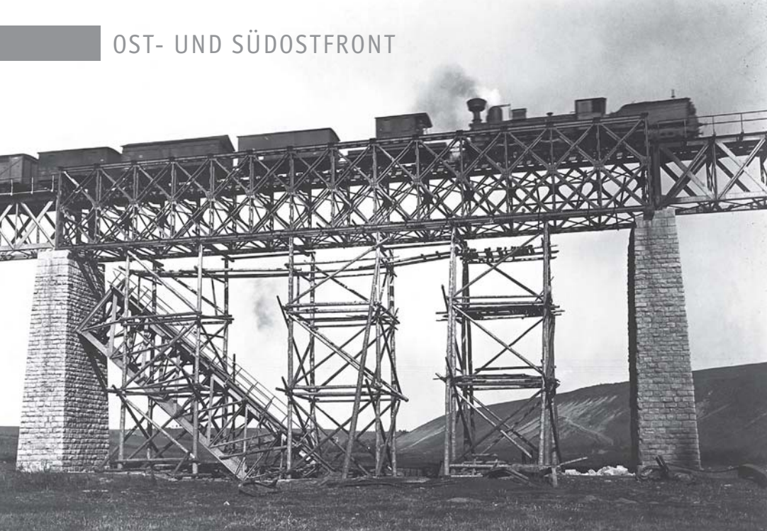
Eine österreichische Lok der Reihe 73 passiert mit ihrem Zug die 1917 von der deutschen Reserve-Eisenbahnbaukompanie Nr. 8 reparierte Brücke über die Niczlawka.
