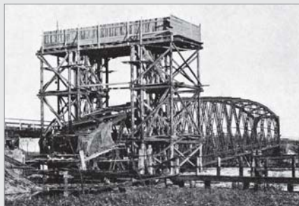
Heben der gesprengten Deimebrücke (Ostpreußen) durch Grün & Bilfinger.
