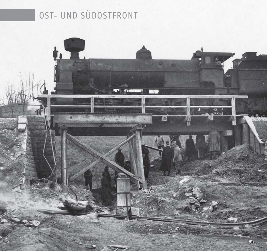
Von den Russen beim Rückzug gesprengt, nun repariert: Gölisdorf-Fünfkuppler der Reihe 80/180 und Uniformmützen weisen auf Brücke der österreich-ungarischen Heeresbahn.
