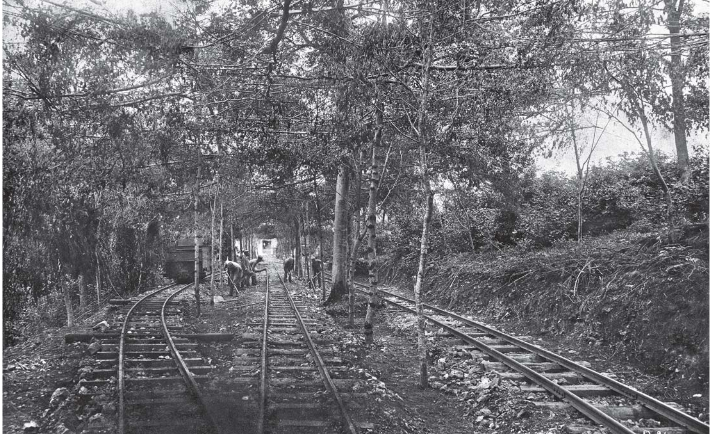
Eisenbahnpioniere beim Ausbessern der Argonnenbahn. Dem Schutz vor Einsicht aus der Luft dienten die künstlich aufgestellten Birken.
