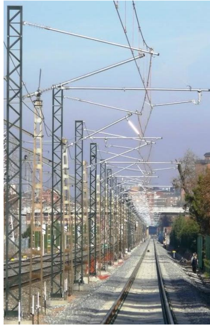
Imagen 5.28: Descentramiento de la catenaria, tramo de vía única LAV [4].
